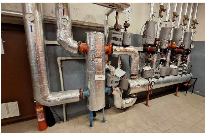
Obrázek 12 – Kombinovaný rozdělovač/sběrač topných okruhů
