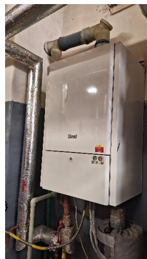
Obrázek 2 – Kotelna v přízemí budovy B; 2x stacionární kotel Hoval CompactGas (240), 1x závěsný kondenzační kotel Hoval TopGas (60)
