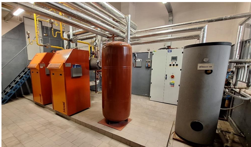
Obrázek 2 – Kotelna v přízemí budovy B; 2x stacionární kotel Hoval CompactGas (240), 1x závěsný kondenzační kotel Hoval TopGas (60)
