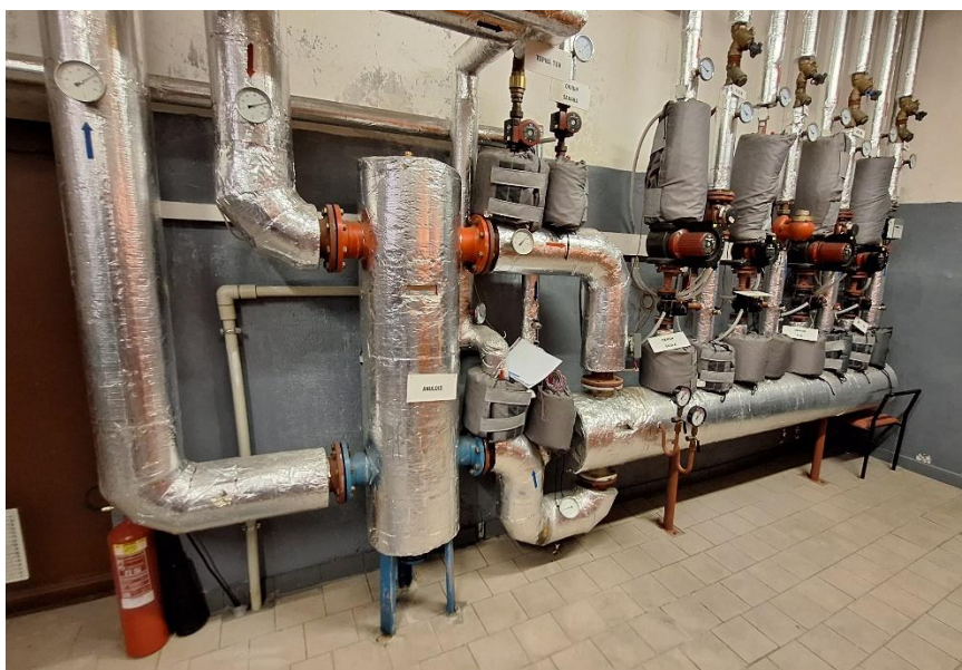
Obrázek 3 – Kombinovaný rozdělovač a sběrač topných okruhů
