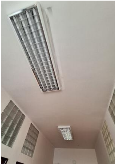
Obrázek 13 – Stávající zářivková svítidla (chodba)
